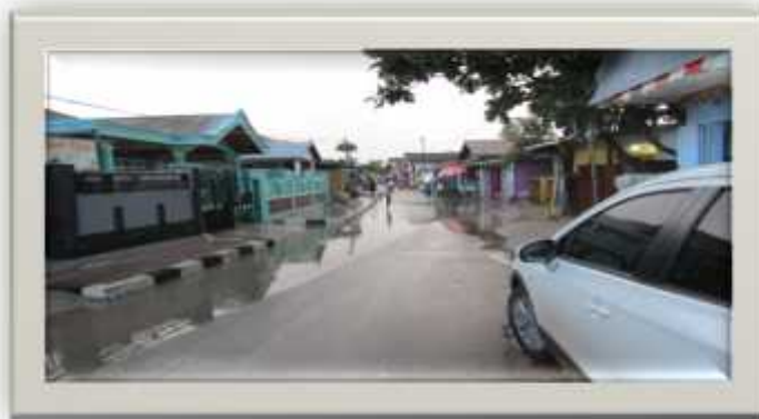
Gambar 1.1 Genangan Lokasi : Jln. Damai
