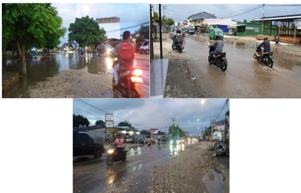
Gambar 1.1 Kondisi genangan air dan kerikil yang ada dibadan jalan(Jalan Tuak Daun Merah (TDM), Kelurahan TDM, Kecamatan Oebobo, Kota Kupang)
