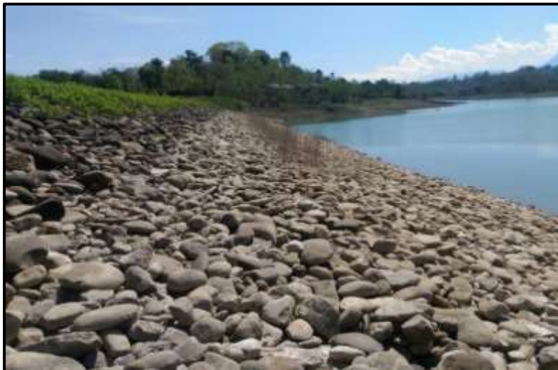
Gambar 4.17 : Kondisi Pagar Disekeliling Kolam Tampungan Sumber : Dokumentasi (2018)
