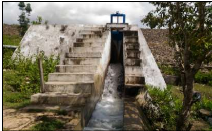
Gambar 4.26 : Kondisi Bak Air Keperluan Sawah/Kebun Sumber : Dokumentasi (2018)
