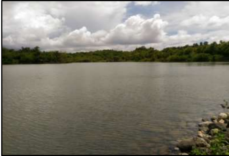
Gambar 4.18 : Kondisi Papan Duga pada Kolam Tampungan
