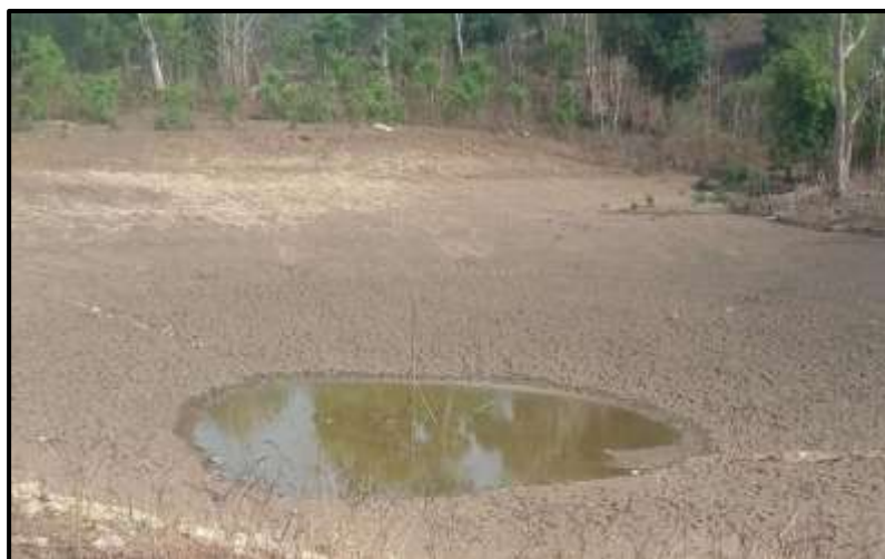
Gambar 4.15 : Kondisi Endapan Lumpur pada Kolam Tampungan
