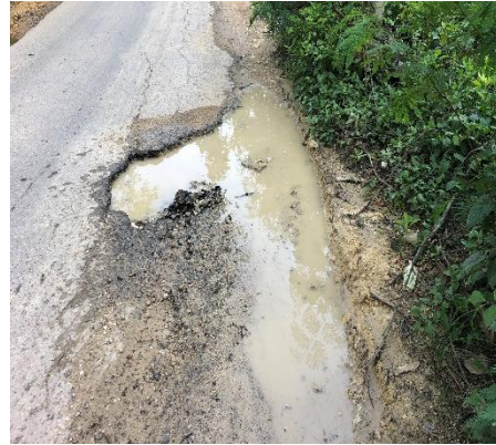
Gambar 1.1 D. Sisi Kanan Jalan
