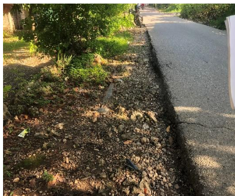
Gambar 1.1 A. Sisi Kiri Jalan
