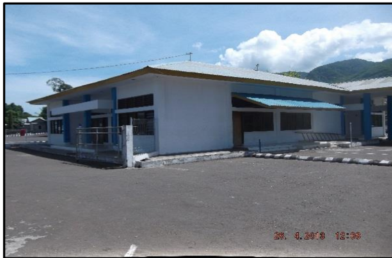
Gambar 1.5. Terminal Penumpang Binongko
