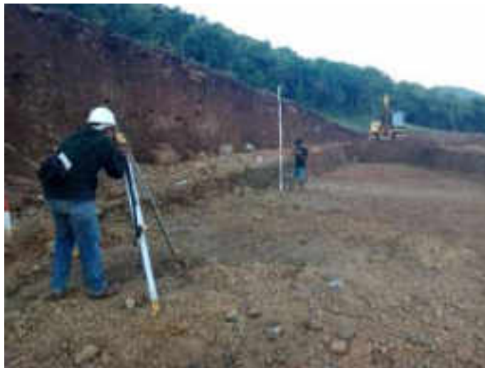
Gambar 4. 7 Pengukuran kemiringan area dumping
