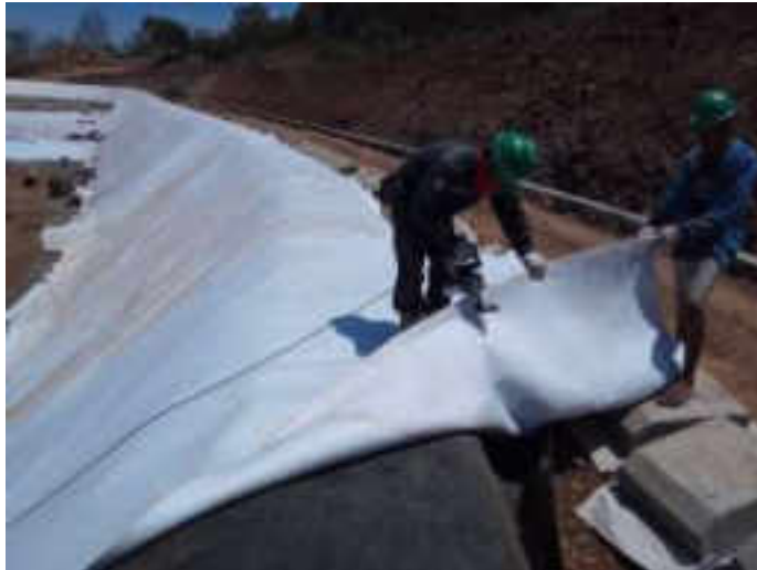
Gambar 4. 8 Pemasangan geomembran dan Geotekstil
