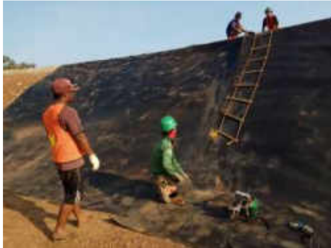
Gambar 4. 19 Proses pemasangan geomembran
