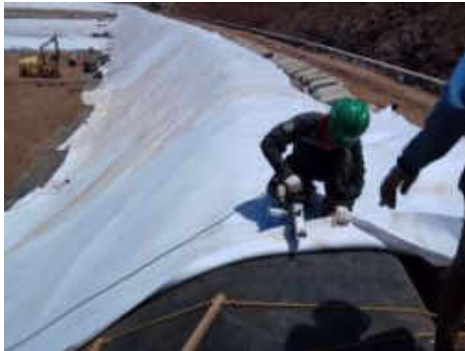
Gambar 4. 20 Proses penyambungan geomembran dan geotextil
