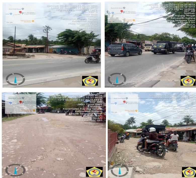
Gambar 1.2. Kondisi Simpang Tiga Jl. Timor Raya – Tilong, Noelbaki, Kecamatan Kupang Tengah, Kabupaten Kupang, Nusa Tenggara Timur (Sumber : Dokumentasi lapangan).
