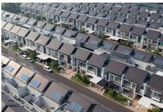
Gambar 5. 22 Panel Surya pada Perumahan
