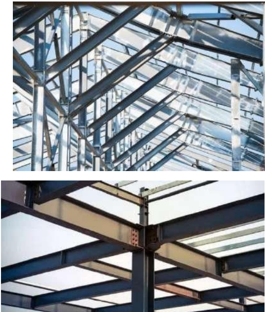
Gambar 23 Struktur atap baja WF.
