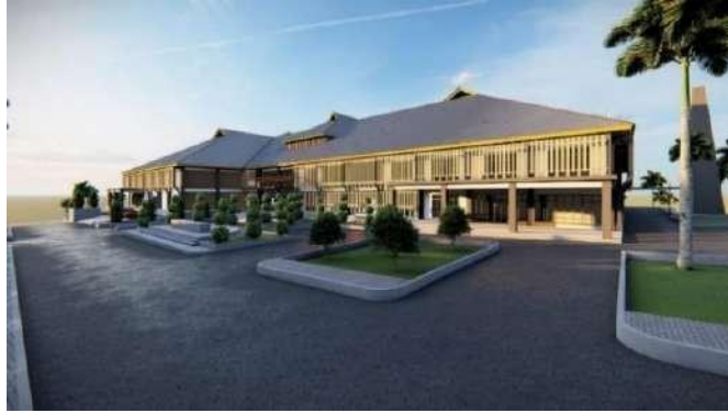
Gambar 25 Bangunan Utama Pengolahan Sampah.
