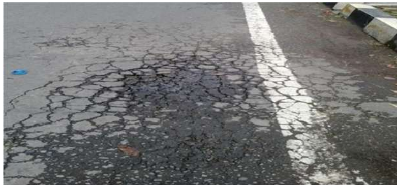
Gambar 2.3 Retak Kulit Buaya
