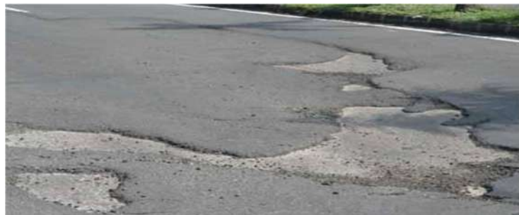
Gambar 2.17. Pengelupasan lapisan permukaan
