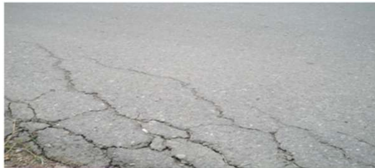
Gambar 2.4 Retak Pinggir
