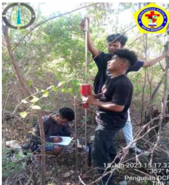
Gambar 4.8. Proses Pengujian DCP Pada (STA 0+050)
