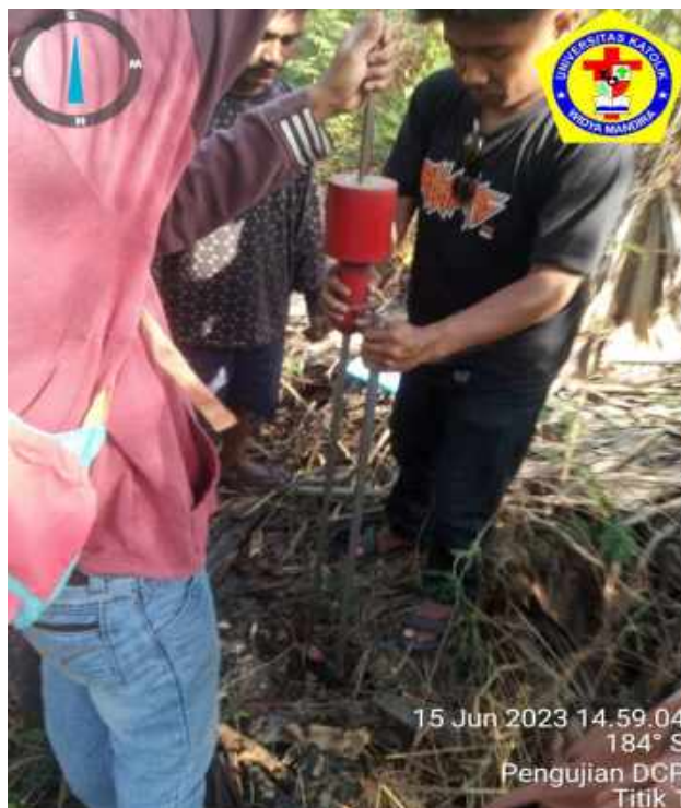
Gambar 4.4. Proses Pengujian DCP Pada (STA 0+000)
