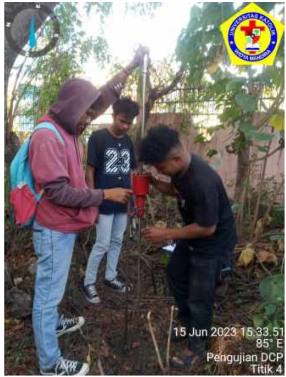
Gambar 4.10. Proses Pengujian DCP Pada (STA 0+075) Sumber: Hasil Dokumentasi Survey (2023)
