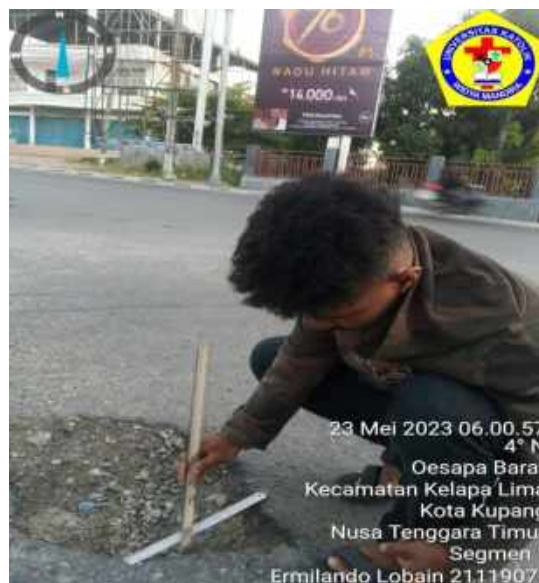
Gambar 4.1. Lubang STA 0+100 – 0+200
