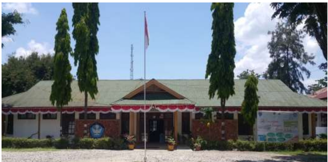
Gambar 2. 1 Gedung Kantor Dinas Pendidikan Kabupaten TTU
