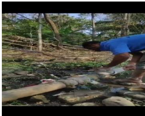
Gambar 5.3 Perbaikan Pipa Yang Rusak
