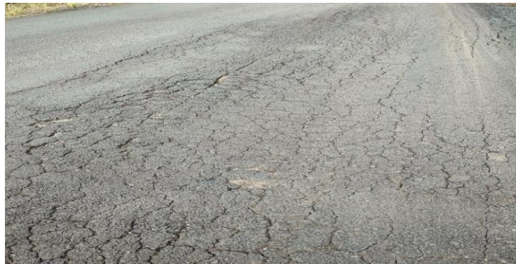
Gambar 2.2 Retak Kulit Buaya
