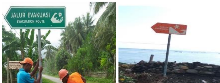
Gambar 4.6 Pemasangan Jalur Evakuasi Banjir di Kampung Ende Kelurahan Kota Ndora dan Kampung Tambak Kelurahan Rana Loba Kecamatan Borong
