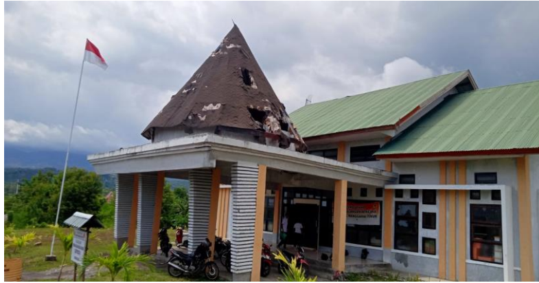
Gambar 4.2 Kantor BPBD Kabupaten Manggarai Timur
