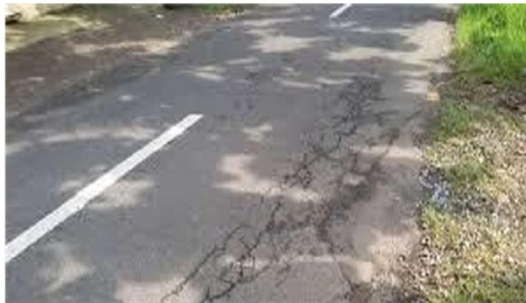
**Gambar 2. 8 Penurunan Bahu Pada Jalan.**
