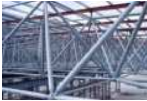
Gambar 4.9.3 Struktur Space Frame
