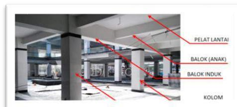
Gambar 4-0-27. Kolom dan Balok Bangunan.
