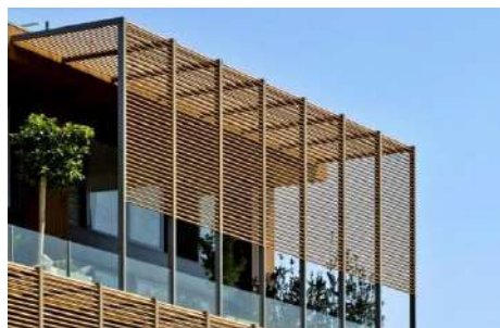
Gambar 4.5 Fasad Bangunan Sumber : (www.emporioarchitect.com)
