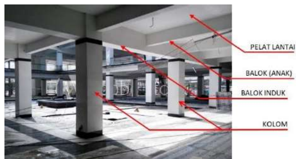
Gambar 5.32 : Konsep Struktur Tengah Balok Sumber : Analisa pribadi 2024
