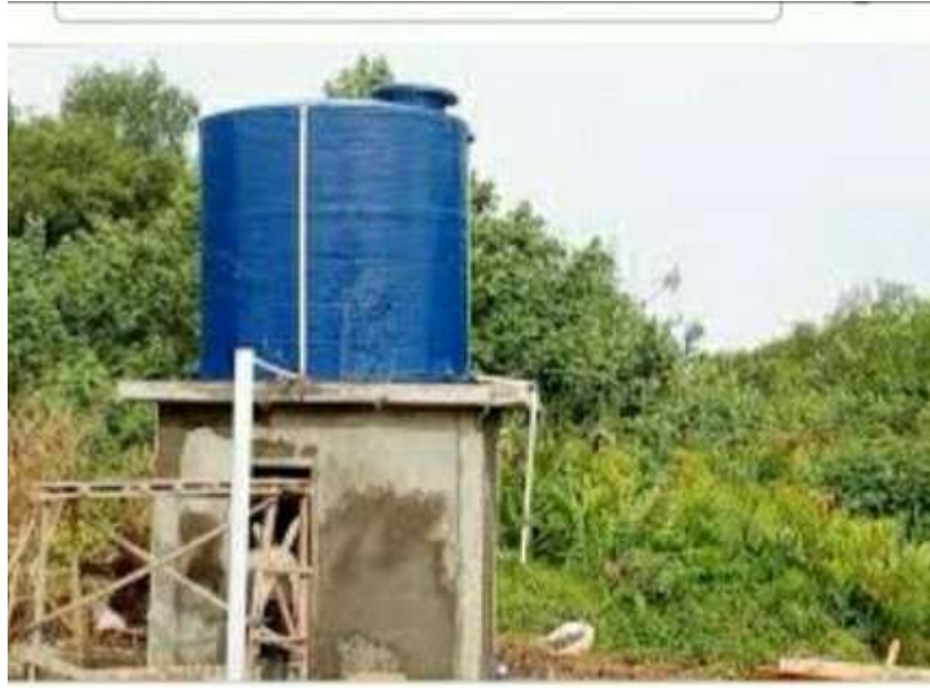
Gambar 5 Pembangunan sarana air bersih
