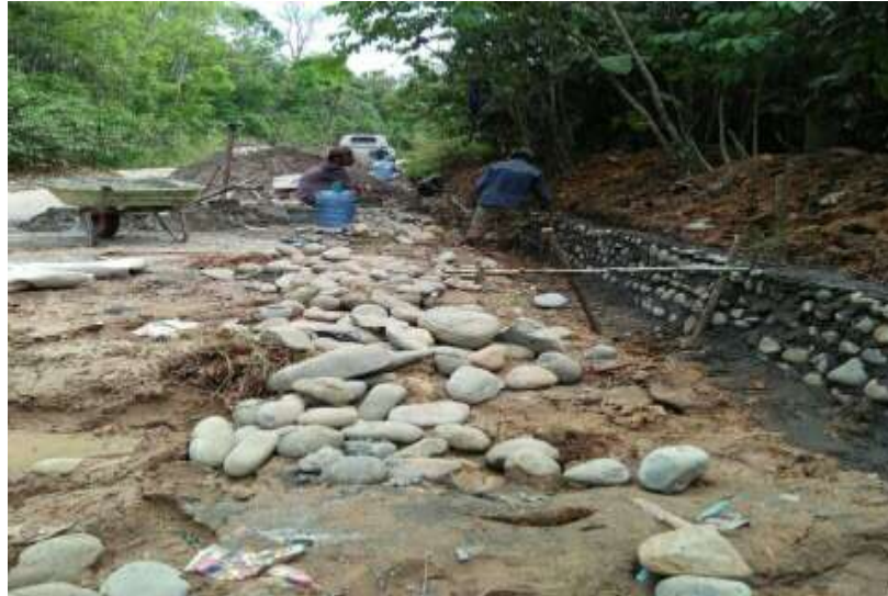
Gambar 6 Pembangunan jalan raya
