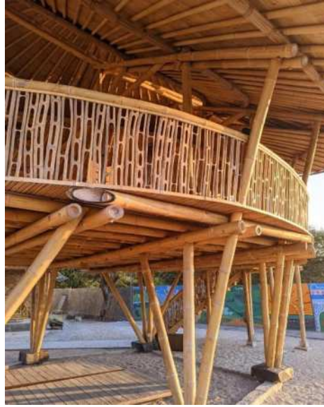
Gambar 5. 20 Bambu sebagai Struktur Tengah (Sumber : Dokumentasi Pribadi, 2024)
