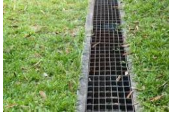
Gambar 5. 11 Saluran Drainase Tertutup
