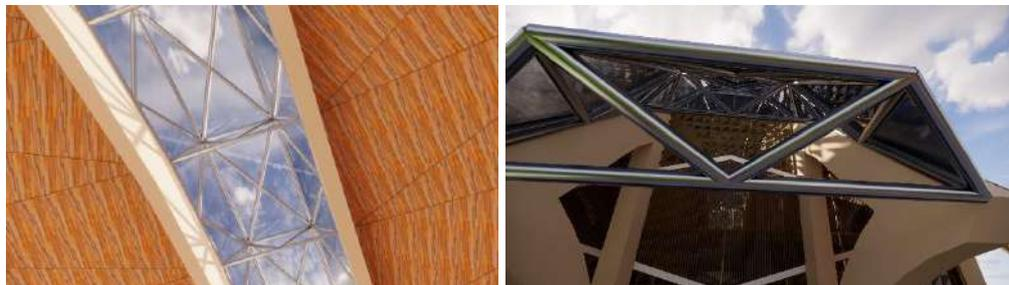
*Gambar 5. 33 Baja Bulat Hollow Sebagai Material Struktur Atas*
