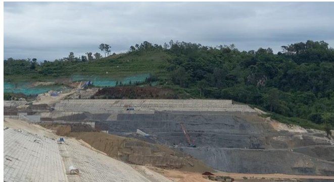
Gambar 1. 1 Kondisi Hilir Bendungan Temef
