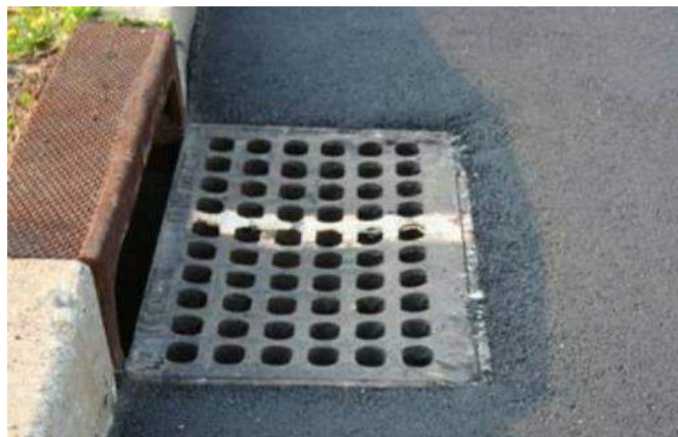
Gambar 2.21 Bentuk Catch basin/watershed
