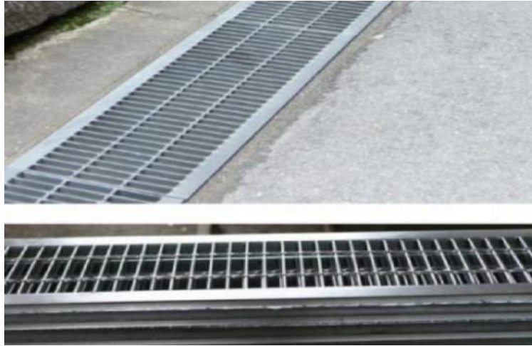
Gambar 2.22 Bentuk Inlet
