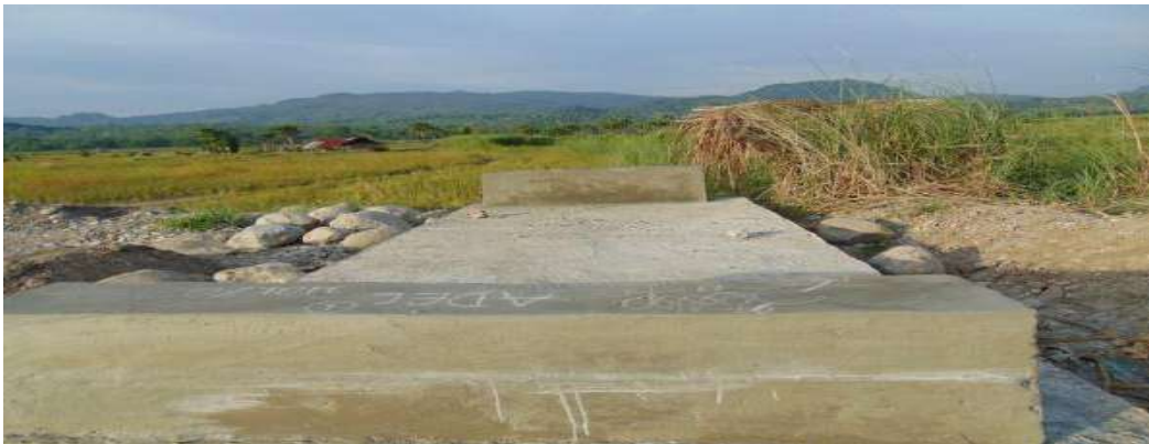
Gambar pembangunan Deker
