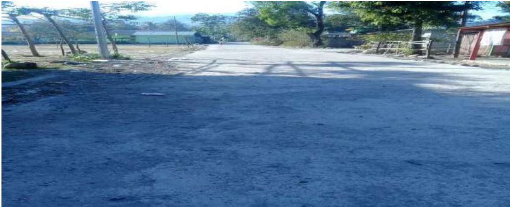
Gambar pembangunan Jalan Raya
