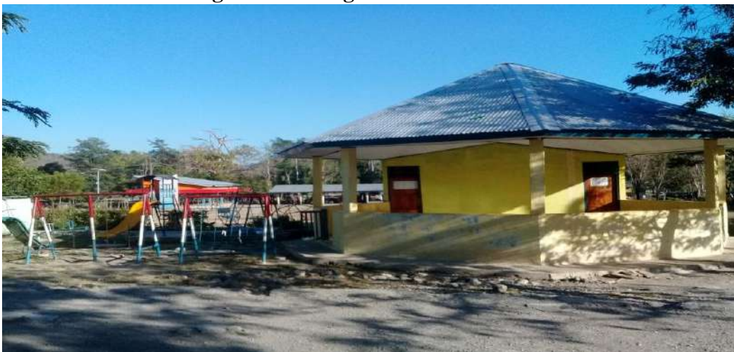
Gambar pembangunan Gedung PAUD
