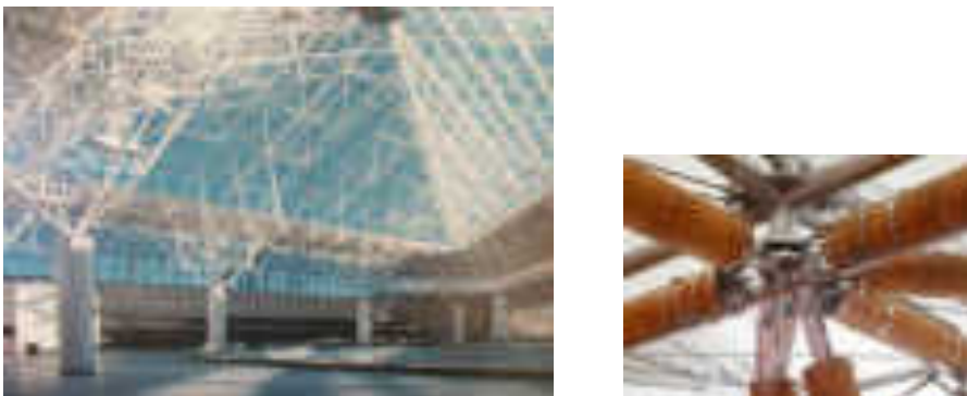
Gambar 5.17 space frame dan bold joint
