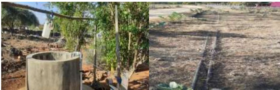
Dokumentasi air bersih sumur bor dari perkampungan warga
