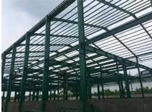
Gambar 5.11 struktur rangka baja wf
