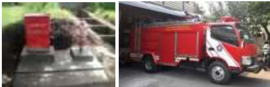
Gambar 5.29 Hydrant dan mobil pemadam kebakaran
