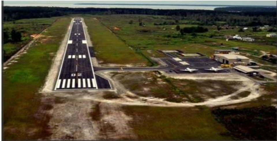
Gambar 1.1 Kondisi Existing Bandar Udara Soa Bajawa
