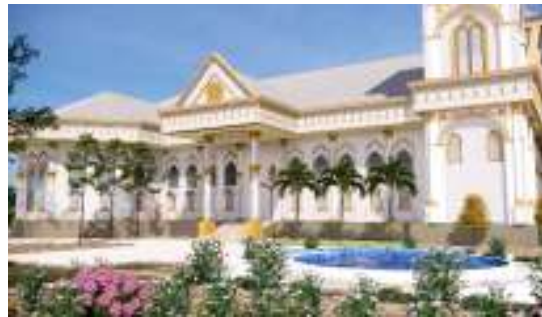
Gambar 5. 21: Penerapan fasad atau selasar panjang pada bangunan utama gereja yang menjadi sirkulasi horisontal
