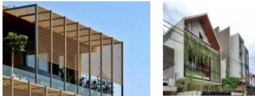
Gambar 66. Penerapan Secondary Skin Dan Tanaman Rambat Pada Bangunan
